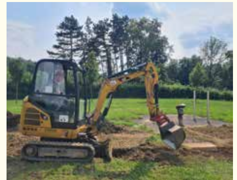
Geschäfts- und Baggerführer im Einsatz
